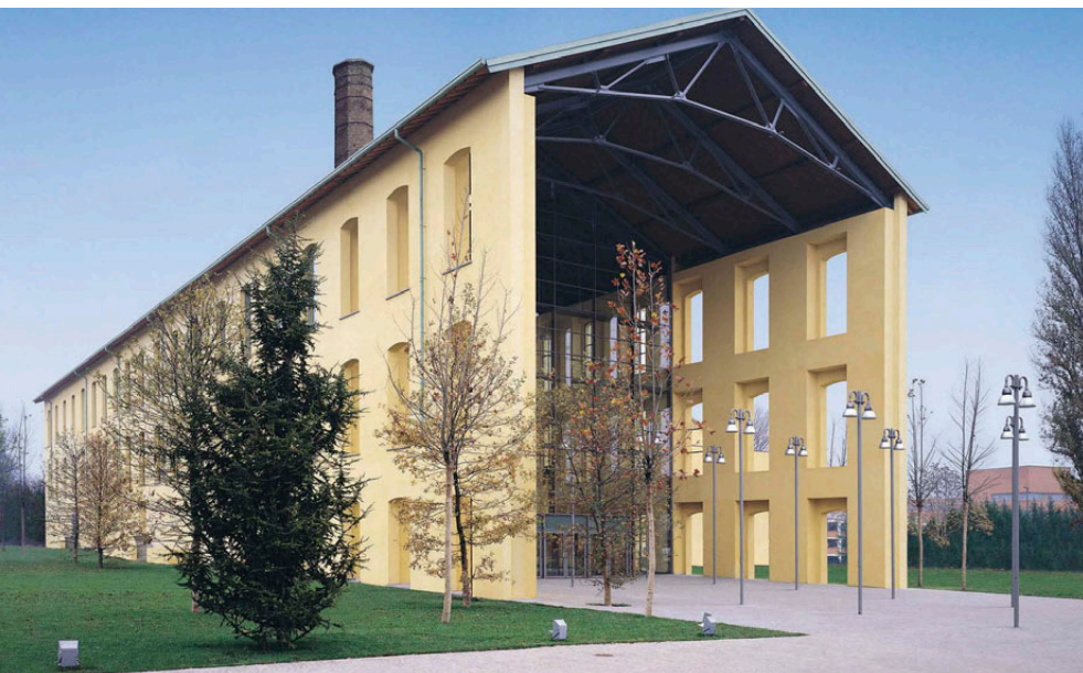
Grandi vetrate caratterizzano l'edificio dell'Auditorium Niccolò Paganini, restaurato da Renzo Piano, nell'ex stabilimento Eridania. Foto: Studio Carra
